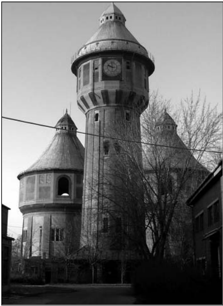
8. fotó. Az egykori Óbudai Gázgyár telephelyén a már leállított technológia szerves részét képező három tartályból és egy víztoronyból álló tartálycsoport
