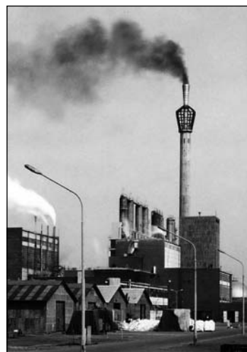
4. fotó. A jelenleg a MOL-csoporthoz tartozó Tiszai Vegyi Kombinát egykori nitrogénműtrágya-gyárának salétromsav-üzemi véggázkéménye
