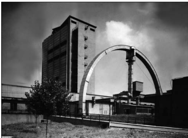
22. fotó. Időközben lebontott kültéri fotópapír-szárító az egykori és a közelmúltban felszámolt váci Forte Fotokémiai Vállalat telephelyén
