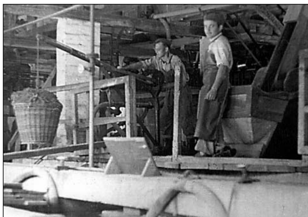
17. fotó. A Kabay János-féle morfingyártás őstechnológiájának betonból készült áztatókádja az 1930-as évekből
