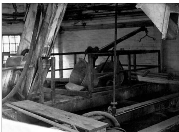
18. fotó. A 17. fotón bemutatott betonkád lebontása (szétverése)
