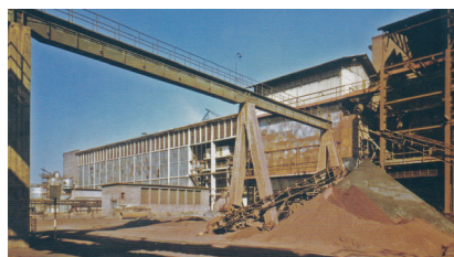
TVM I. SZ. KÉNSAVGYÁR ÉPÍTÉSE
