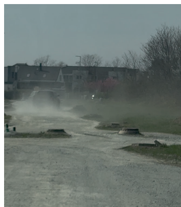
A Szombathely Oladi Plató városrészén épített kőburkolatú út kiporzása (fotó: Kör-Ker Kft.)
