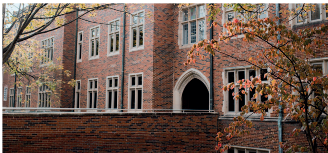
6. ábra. A kémiai épület 1929-ben épült része. A híd a Dabney Hall 5. emeletére vezet
